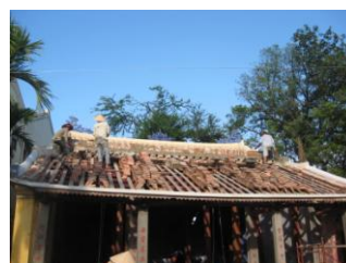
Thi công tu bổ di tích Hội An Tiên Tự, tháng 5/2010
